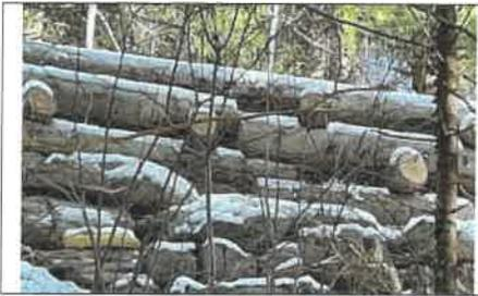
Die einzelnen Etagen der **Krainerwand** werden aus langen Blochen (Läufern) und kürzeren Querhölzern (Klammern) errichtet.
